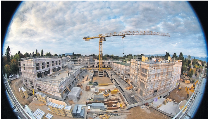
Détail d'une photo. PATRIZIA CINI
